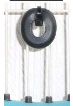
(写真-2) インシュロックで固縛する
